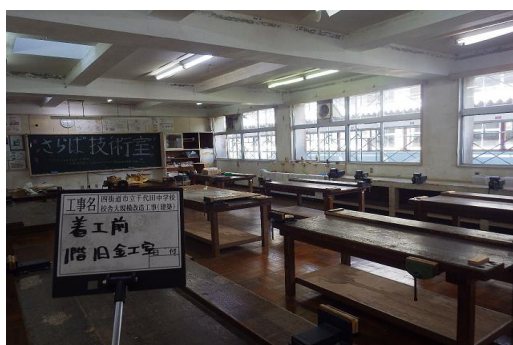
【施工前】(旧金工室)
